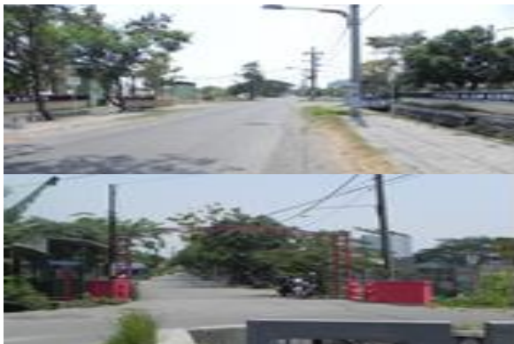
Gambar 4. Kondisi Jalan di sekitar Kelurahan Gunung Anyar (Sumber: Survei, 2015)
