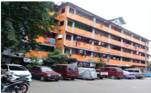
Gambar 3. Kondisi Bangunan Rusunawa Warugunung (Sumber: Dokumentasi Survei, 2018)
