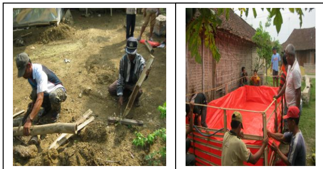
Gambar 3.11 Proses Pembuatan Kolam Lele Berangka Bambu
