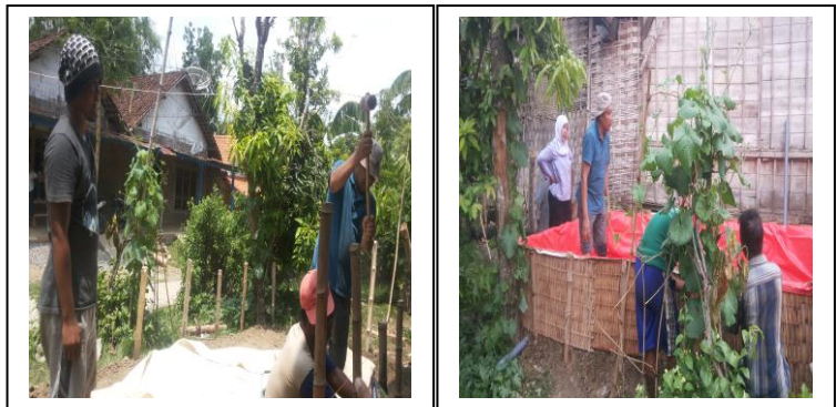
Gambar 3.12 Proses Pembuatan Kolam Berangka Anyaman Bambu (Sesek)
