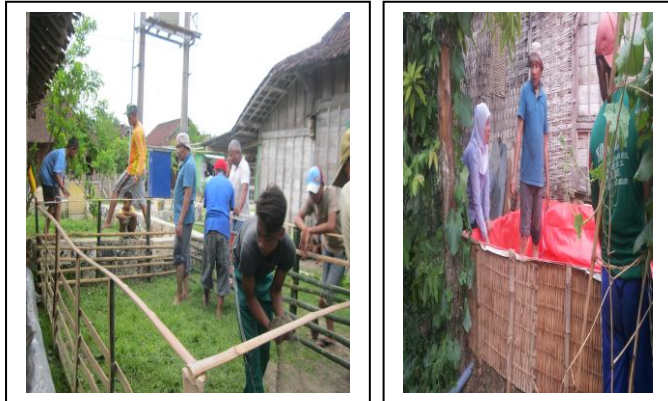
Gambar 3.10 Kolam Lele Dengan Rangka Bambu atau Sesek
